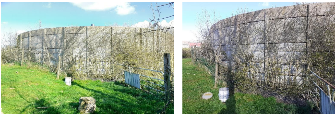
Figure 8 : fosse extérieure STO2, clôture et dispositif de contrôle de l'étanchéité STO2
